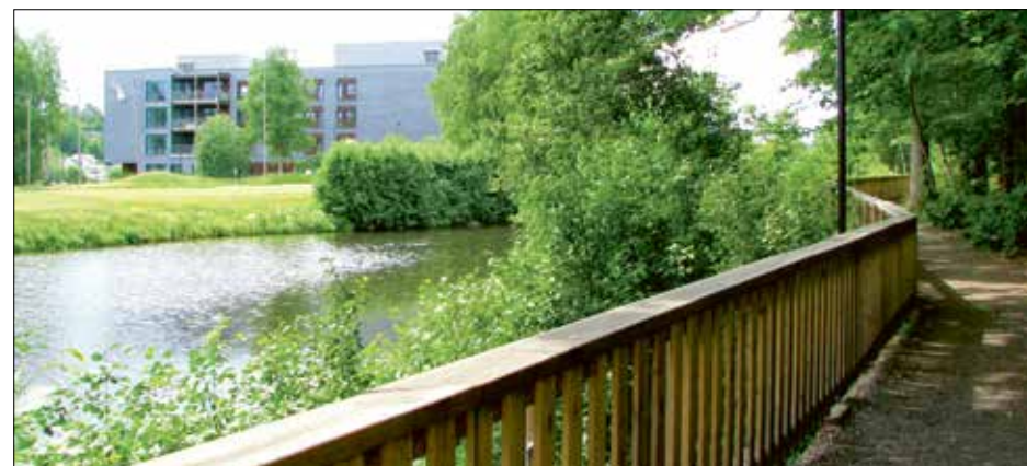
Glimt fra Ulleruddammen med gangstien fra Ullerud helsebygg i bakgrunnen og videre opp til Follo museum. Ullerud helsebygg i massivtre åpnet i 2017, og samme år ble også den fine gangstien tatt i bruk. (Foto: Sven Lindblad, juli 2020).
