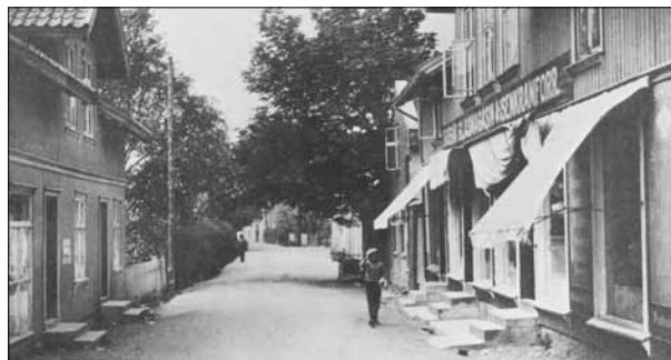
Glassmagasinet t.h. Rommerud t.v. og Eldresenteret i enden av gaten.
